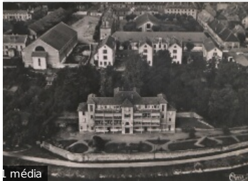
DOLE (Jura). Vue aérienne.11256 le préventorium. Pavillon PasteurCIM
