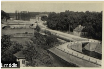
17 . Dole - Les écluses
