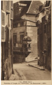
116. Dole (Jura) - Poivrière à l'angle de l'Hôtel-Dieu, rue Bauzonnet (1686)
