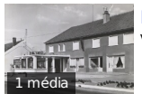
Hôtel Bon accueil. Avenue de Genève. DOLE (Jura). Téléphone 426« Les éditions de l'Est » E. Protet, 15, rue du Parlement. DOLE (Jura) VEL/CP/2/38
